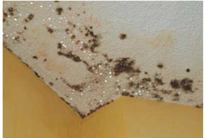
Figure 3 Condensation sous dalle de toiture
